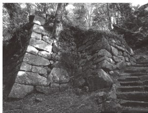
天守曲輪の石垣（崩落前）
