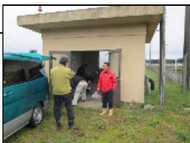
機場の操作点検及び 送水管点検
