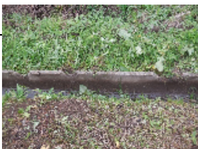
<用水路の老朽化による劣化>
