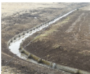
<機能回復された排水路>
