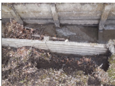
<法面の陥没>
