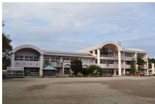
▲大原小学校に設置された太陽光発電設備
