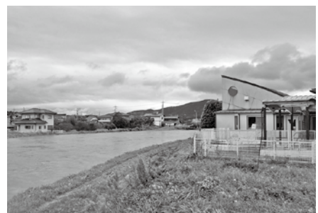
台風18号によるくるす保育所わき沼沼川の増水
