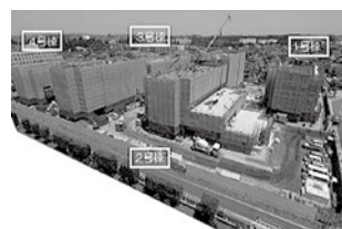
災害公営住宅の建設状況 (平成26年6月9日時点)
