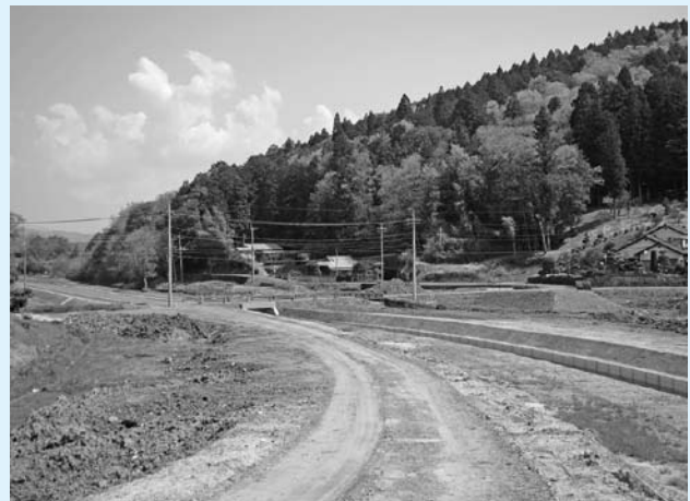
施工中の来栖・本戸線
