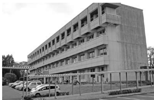
耐震補強工事が行われる稲田中学校
