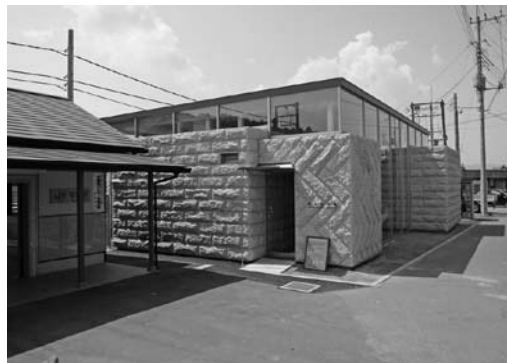
稲田駅前に建設された「石の百年館」
