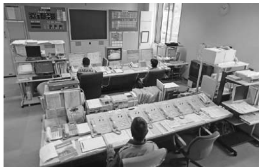
消防本部通信指令室
