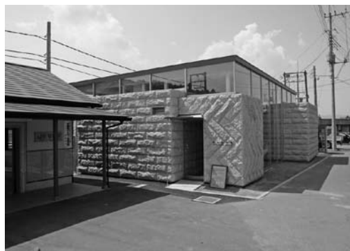
稲田駅前に建設された「石の百年館」
