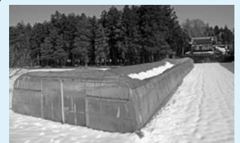
降雪により倒壊したビニールハウス
