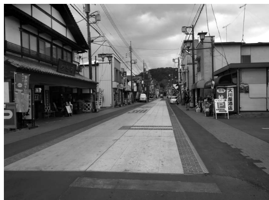
石張舗装整備が進む笠間稲荷門前通り
