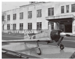
県立こころの医療センター敷地内に残る司令部庁舎
