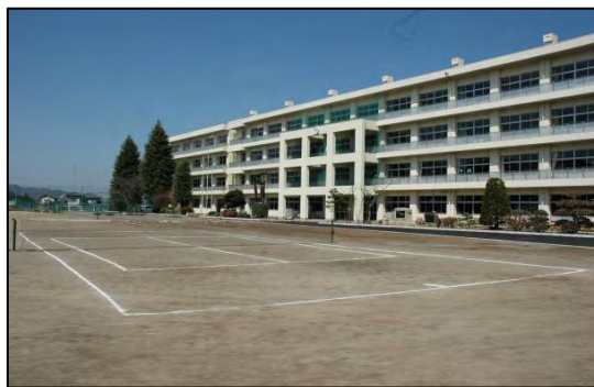
耐震補強された友部中学校
