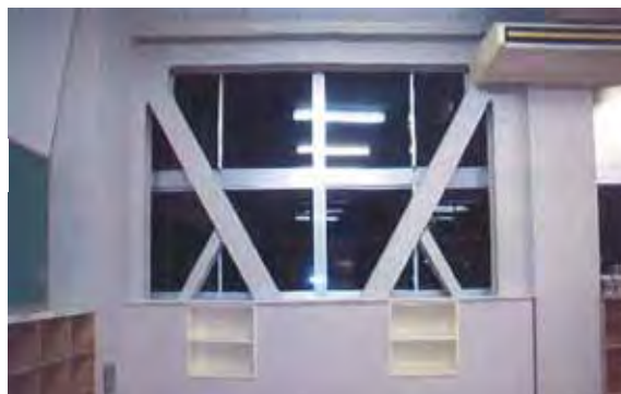
耐震補強が施された教室
