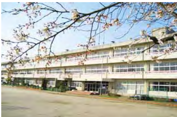
耐震補強工事が予定されている宍戸小学校
