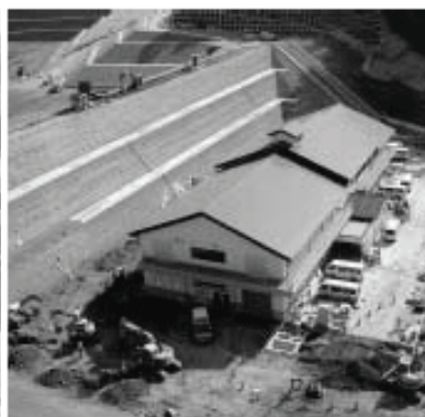
浸出水処理施設
