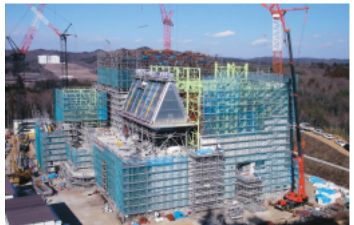
今年8月の操業に向けて工事が進む「エコフロンティアかさま」(写真：溶融施設)
