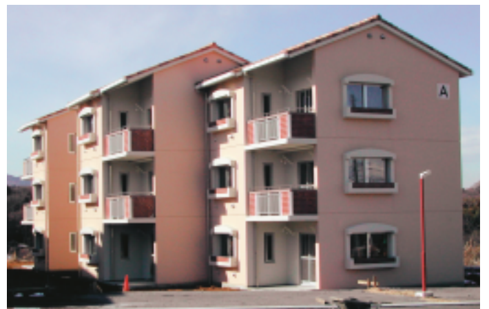
福原地内に完成した市営住宅（RC造3階建・22戸）
