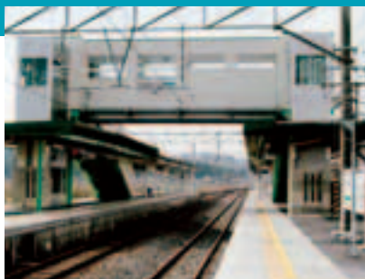
エレベーター
