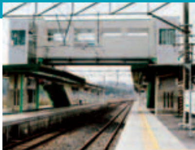
エレベーター
