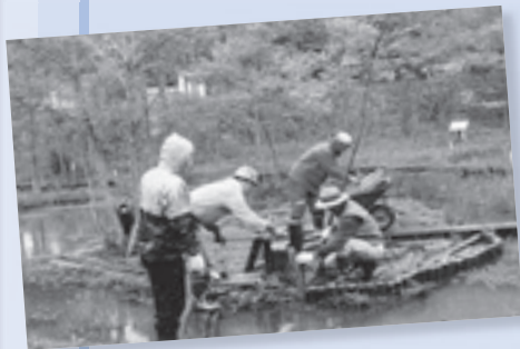
中の島の補修作業(天神の里)
