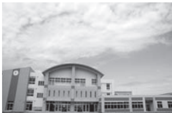
完成した岩間中学校校舎
