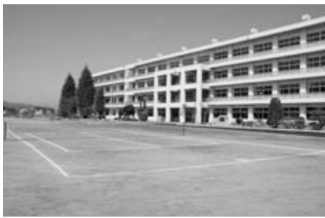
耐震補強された友部中学校
