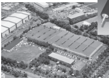
(左)工場外観(右)印刷用ゴムロール
