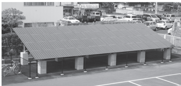
平成 22 年 3 月に設置された市立病院の太陽光発電システム（出力 10kW）、このほか、ソーラー LED 屋外照明 6 基と屋内 LED 照明 52 基が設置されました。
