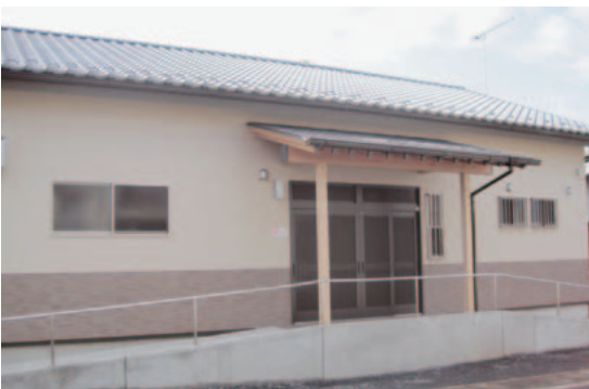
下安居区コミュニティセンター
