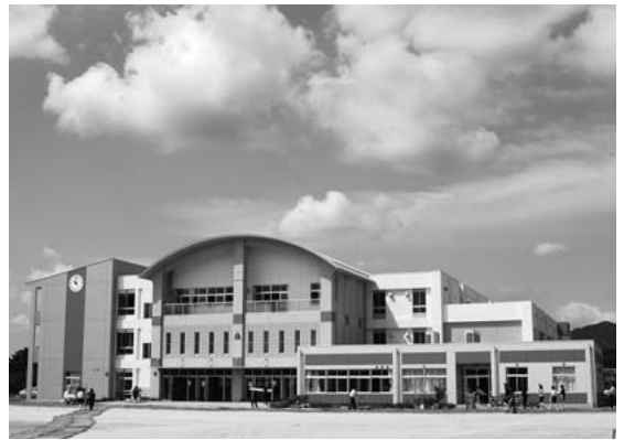
平成21年8月 岩間中学校新校舎竣工
