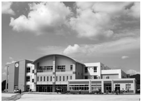
平成21年8月 岩間中学校新校舎竣工
