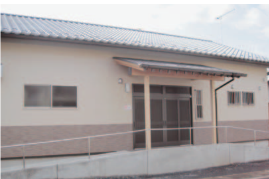
下安居区コミュニティセンター
