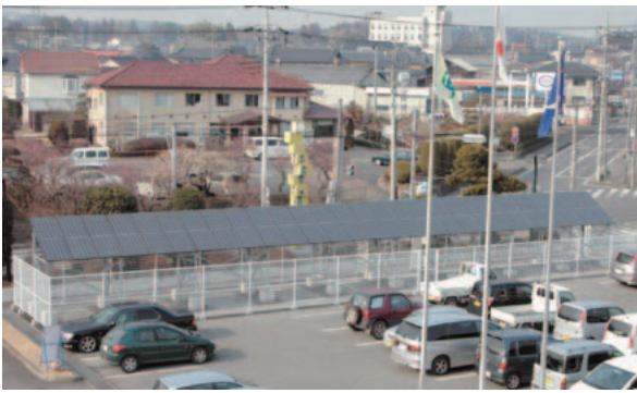
市役所本所に設置された太陽光発電システム
