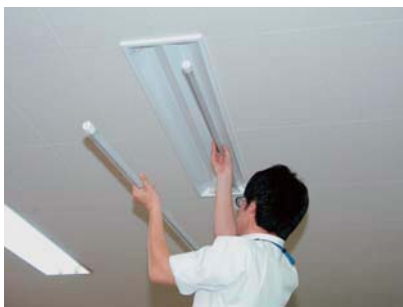
照明を間引きするため、 蛍光管をはずす担当職員 (笠間市役所本所)
