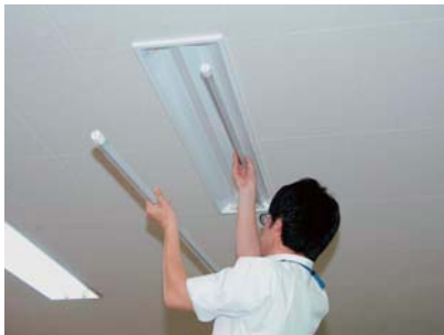
照明を間引きするため、蛍光管をはずす担当職員 (笠間市役所本所)
