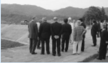
笠間 IC（仮称）建設現場
