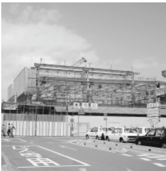
建設中の友部駅橋上化及び自由通路
