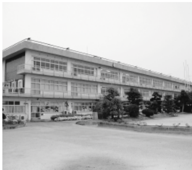
耐震化優先度調査の結果により整備を図る岩間中学校
