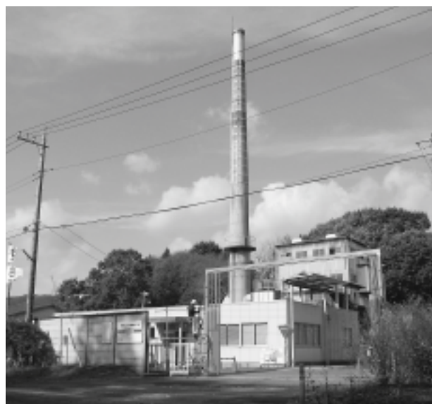
解体工事中の清掃センター
