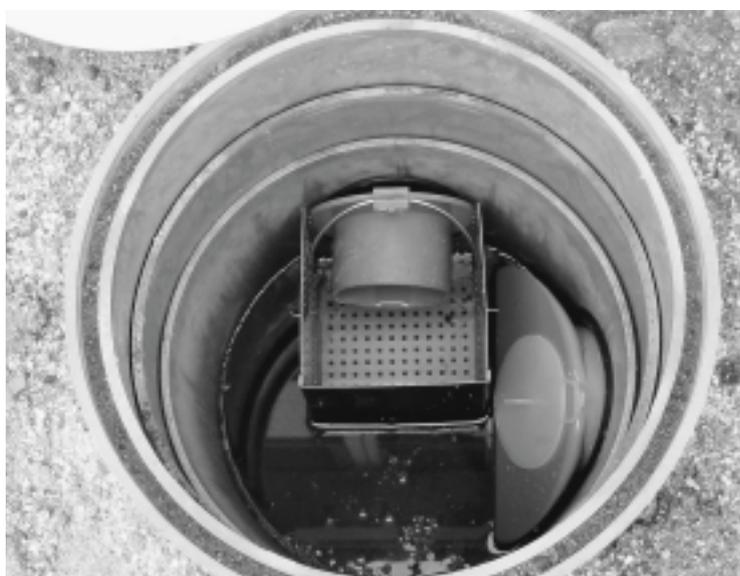
汚水枦に設置される油脂遮断装置
