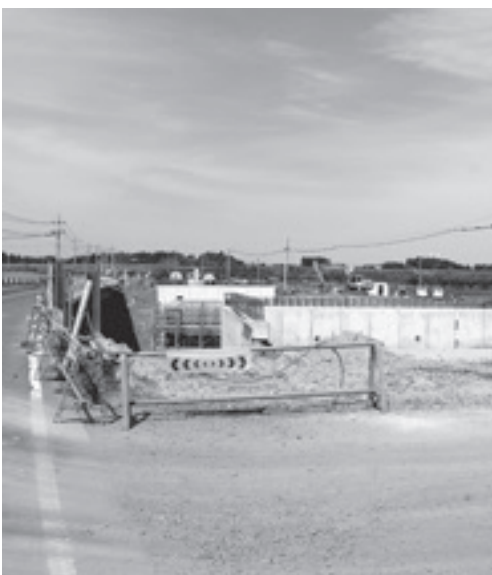
友部地区と岩間地区を結ぶ大古山橋の建設
