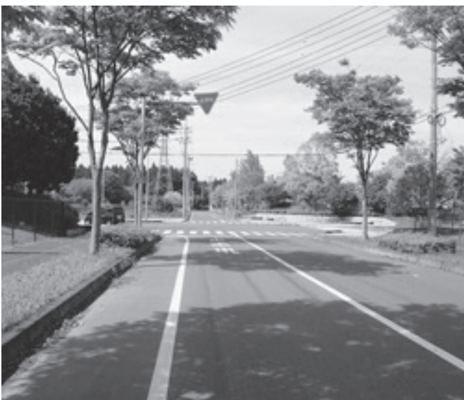
信号機が設置されていない岩間工業団地内の交差点
