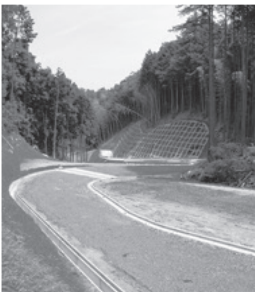
整備が進められている林道「本戸前山線」
