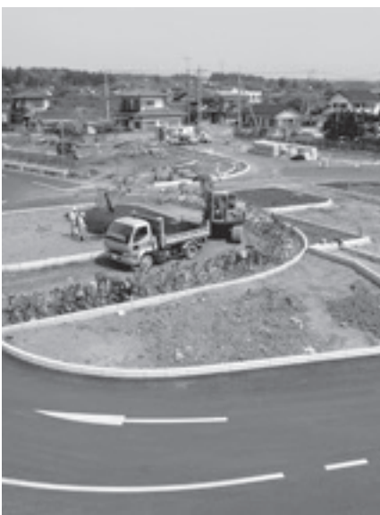
建設が進められる友部駅北口広場
