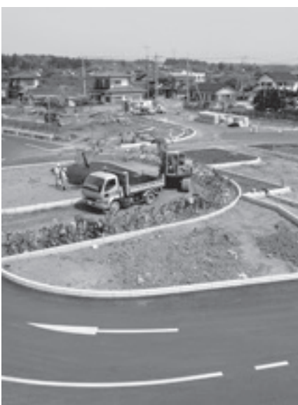
建設が進められる友部駅北口広場
