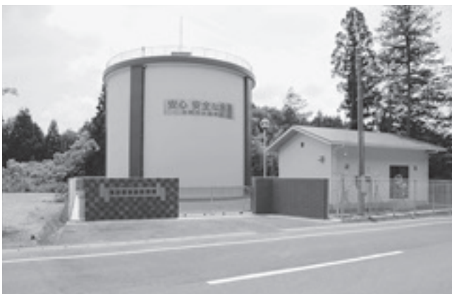
平成20年3月に低圧配水池が設置された南友部地区
