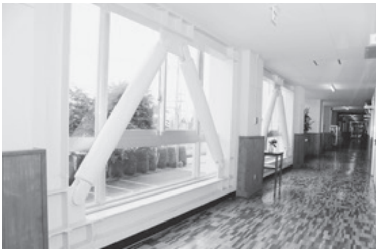
耐震補強工事が完了した友部中学校
