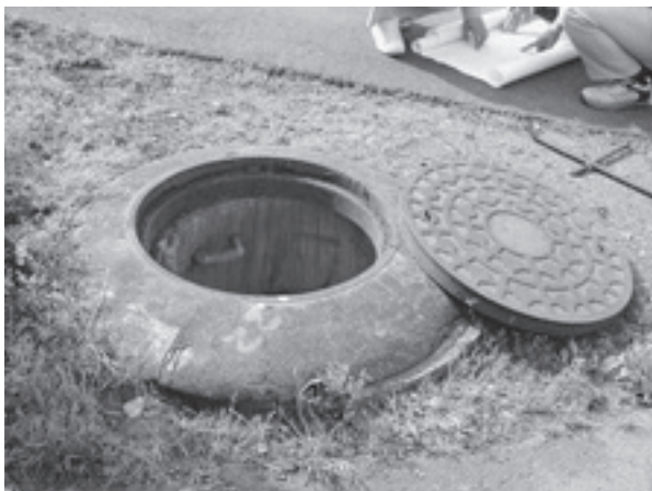
旭町の地下排水路マンホール
