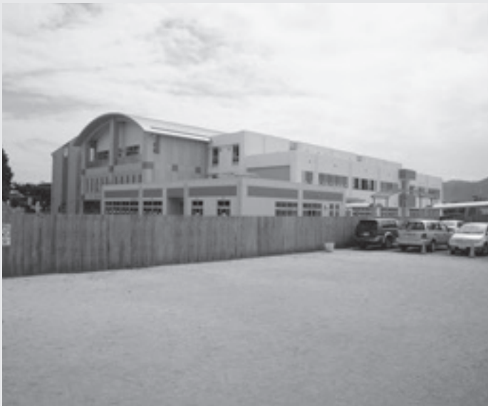
完成が待たれる岩間中学校新校舎
