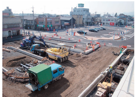
工事が進められている友部駅南口駅前広場
