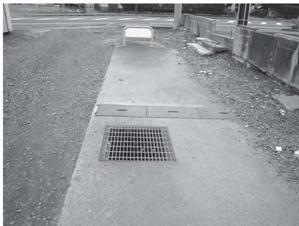
暗渠になっている笠間地区の都市下水路
