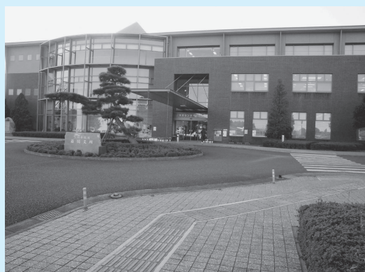
複合施設として整備された市民センターいわま
