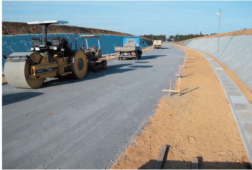
急ピッチで工事が進められています（畜産試験場跡地付近）
