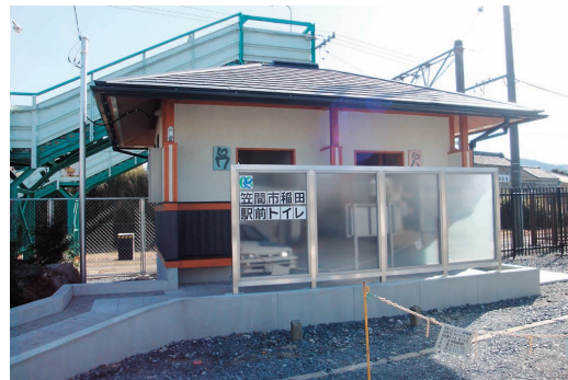
完成した稲田駅前トイレ
