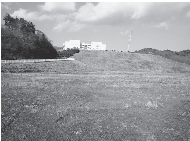
分譲中の笠間東工業団地
