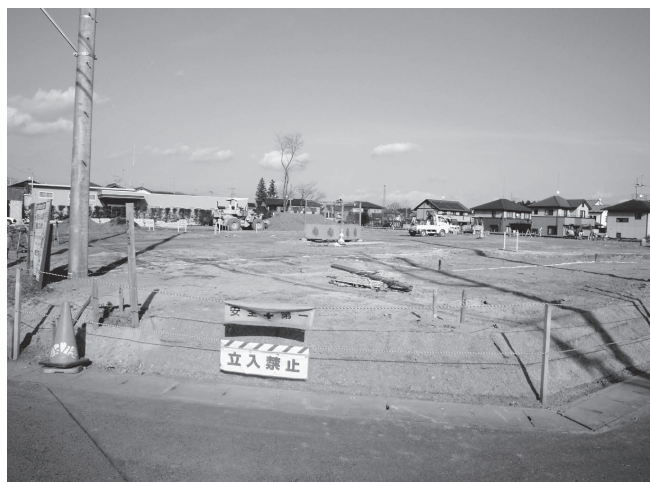
着工した（仮）鯉淵公園
