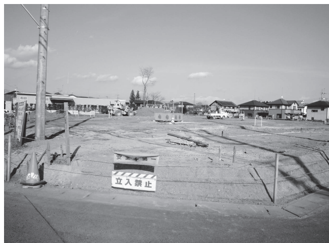
着工した（仮）鯉淵公園
