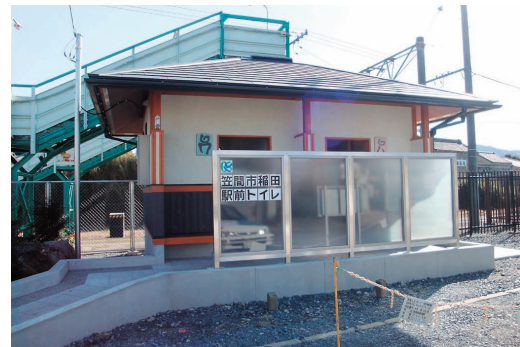
完成した稲田駅前トイレ
