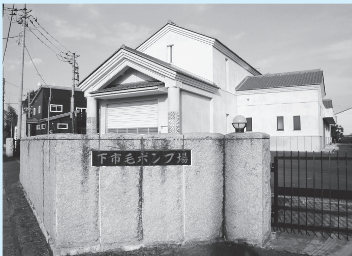
笠間地区の汚水を処理場へ送る下市毛ポンプ場
