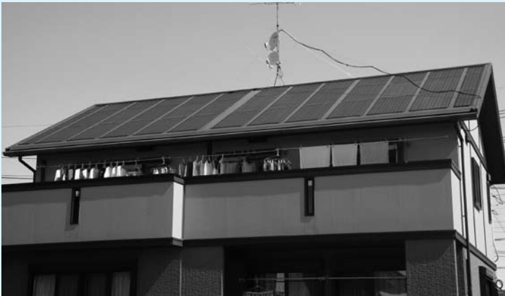
住宅の屋根に設置されたソーラーパネル
