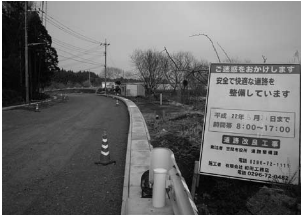
市発注の道路工事
