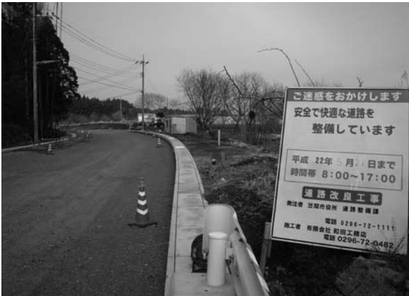
市発注の道路工事
