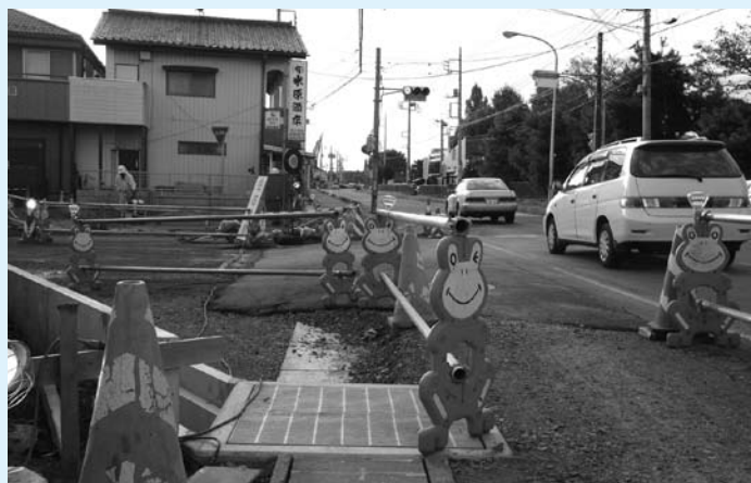
交差点改良工事に合わせて歩道も改良
