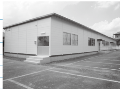
完成した仮庁舎(教育委員会)
