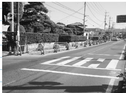
市道の仮復旧の状況（笠間小学校前）
