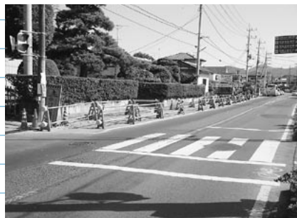
市道の仮復旧の状況(笠間小学校前)
