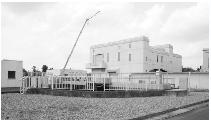
笠岡・友部地区の汚水を処理する終末処理場
