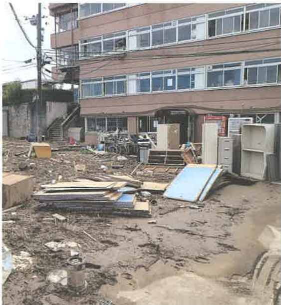
浸水被害を受けた町役場庁舎
