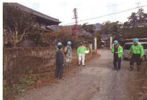
お客様を交え作業手順・安全確認
