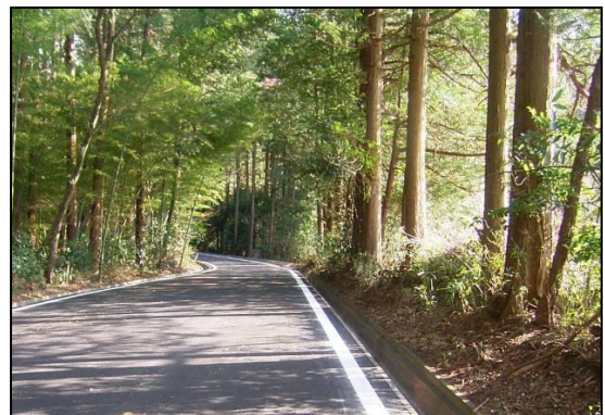
舗装された林道本戸前山線
