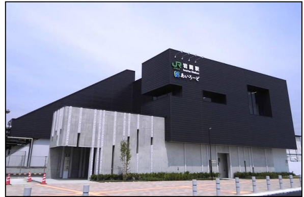
岩間駅駅舎・自由通路
