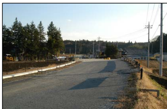
市道大淵飯田線（一丁田橋）
