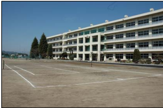
耐震補強された友部中学校
